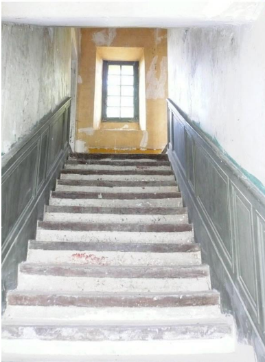
escalier menant à l'étage
